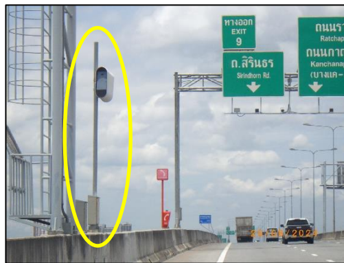
รูปที่ 2-11 กล้องตรวจจับความเร็วของรถที่สัญจรบนถนนของโครงการ
